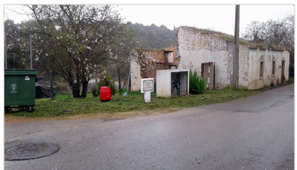
Estrada da Nora dos Velhos - depois
